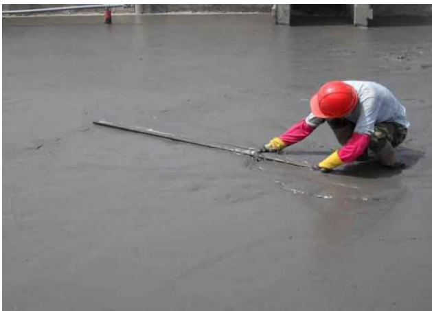
隔音墊上澆 置混凝土
