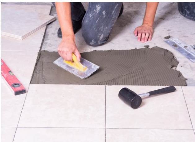
小磚使用 橡皮槌輕 敲固定
