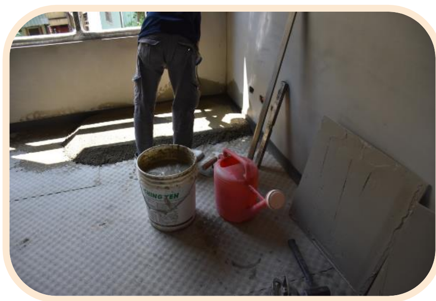
泥漿均勻塗佈於水泥砂施工面上
