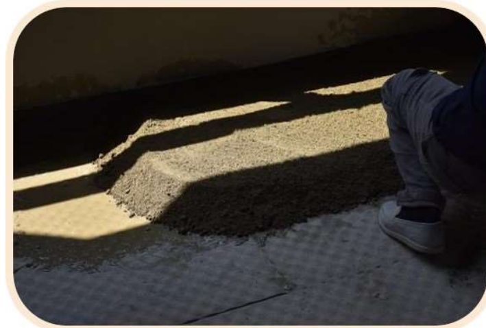
將1:3乾拌水泥砂整平至所需高程
