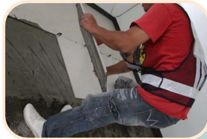
於乾拌水泥砂層上澆置土膏水，並將磁磚鋪平
