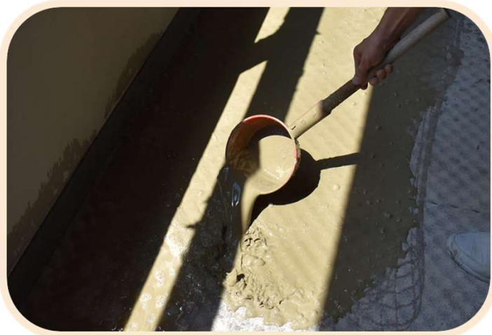
隔音墊上澆置土膏水
