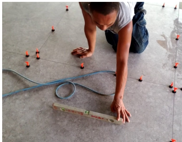
較大尺寸可 使用磁磚調 整器
