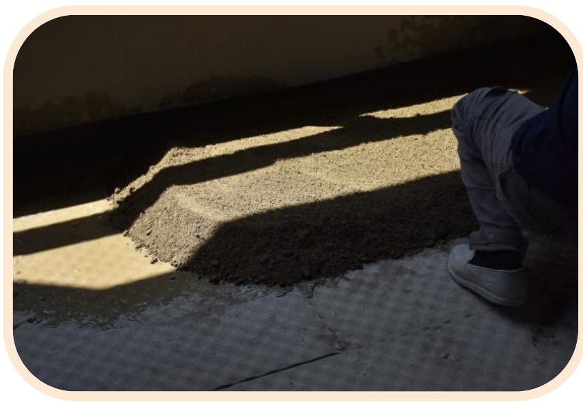
使用鏟刀將水泥砂整平
